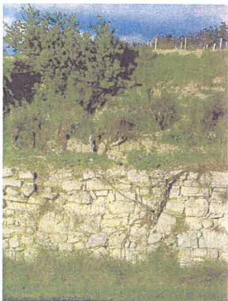
Mur de soutènement en pierre sèche, vigne et amandier, trois composantes des paysages agricoles de Bages
