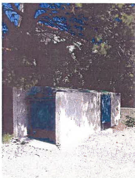
Container permettant la mise en place du tri sélectif
