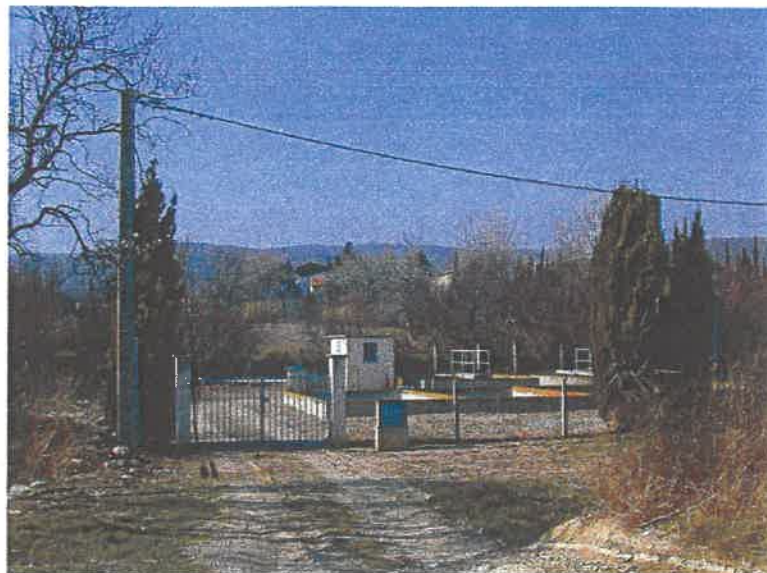
Station d'épuration de Prat de Cest
